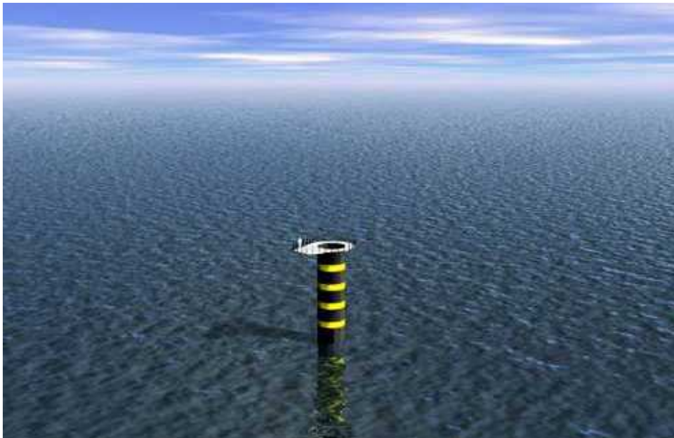
Figuur 4.16 Monopaal met transitiestuk geplaatst in zee
