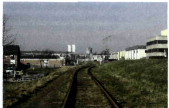
Zichtlijn over het spoor richting watertoren Nyma en VASIM gebouw (vanaf hoek Dijkstraat - stamspoorlijn)
