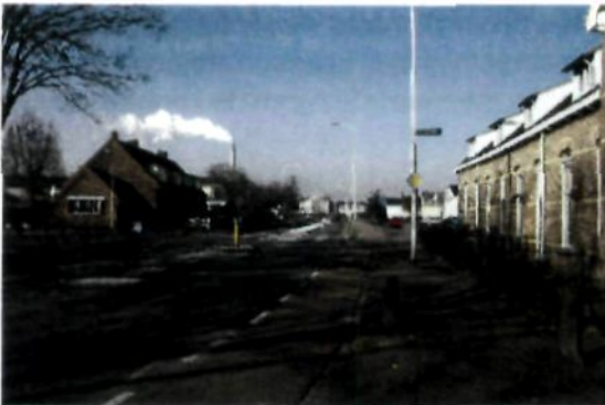
Zichtlijn: Weurtseweg richting PGEM gebouw (monument) met elektriciteitscentrale op achtergrond
