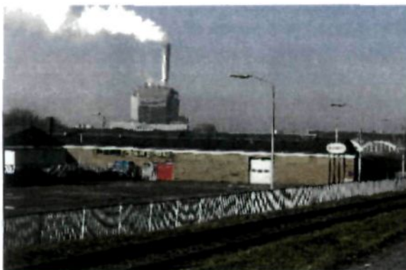
Opvallende bebouwing: Electriciteitscentrale, gezien vanaf de Waalbandijk, (omgeving dijkstraat)
