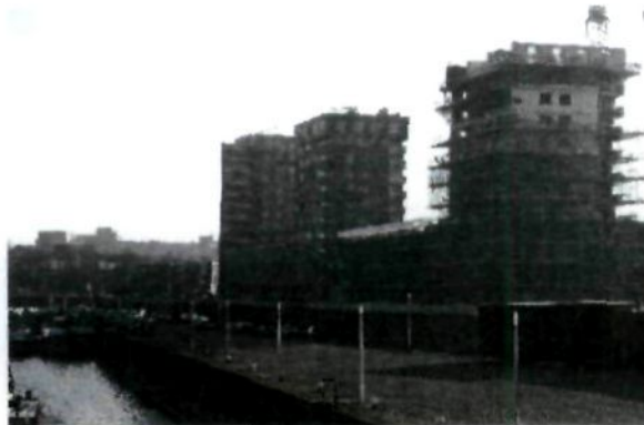
Hoogbouw Waalhaeve aan de haven
