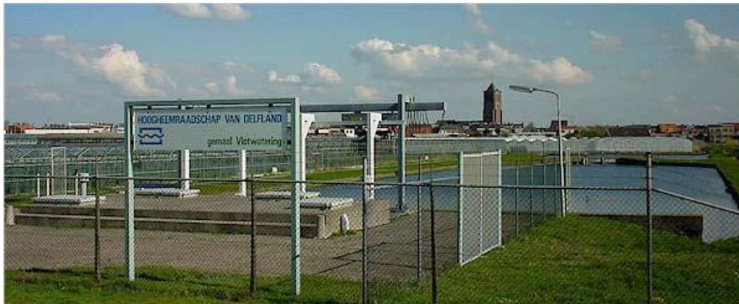
Figuur 4-12: Huidige gemaal Vlotwatering van het Hoogheemraadschap van Delfland tussen Monster en 's Gravenzande (HHD, 2006)
