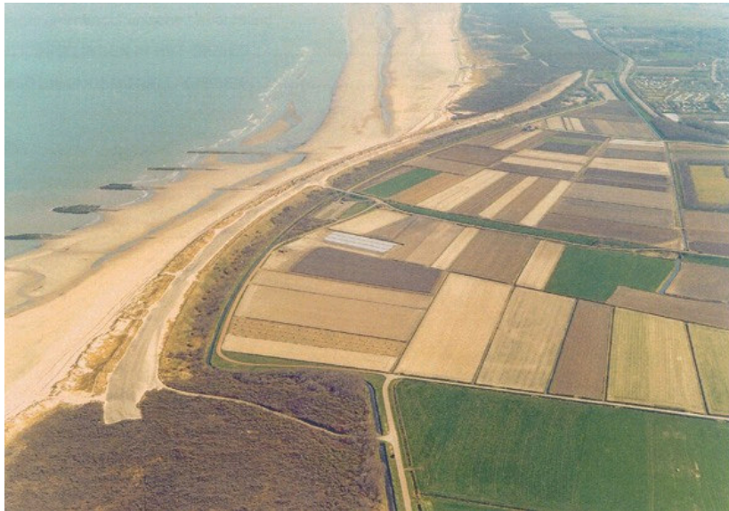
Afbeelding 2: luchtfoto van de zeedijk het Flauwe Werk
