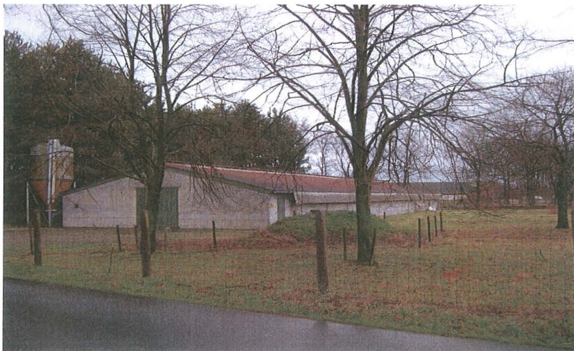
Foto: voorzijde te slopen pluimveestal
