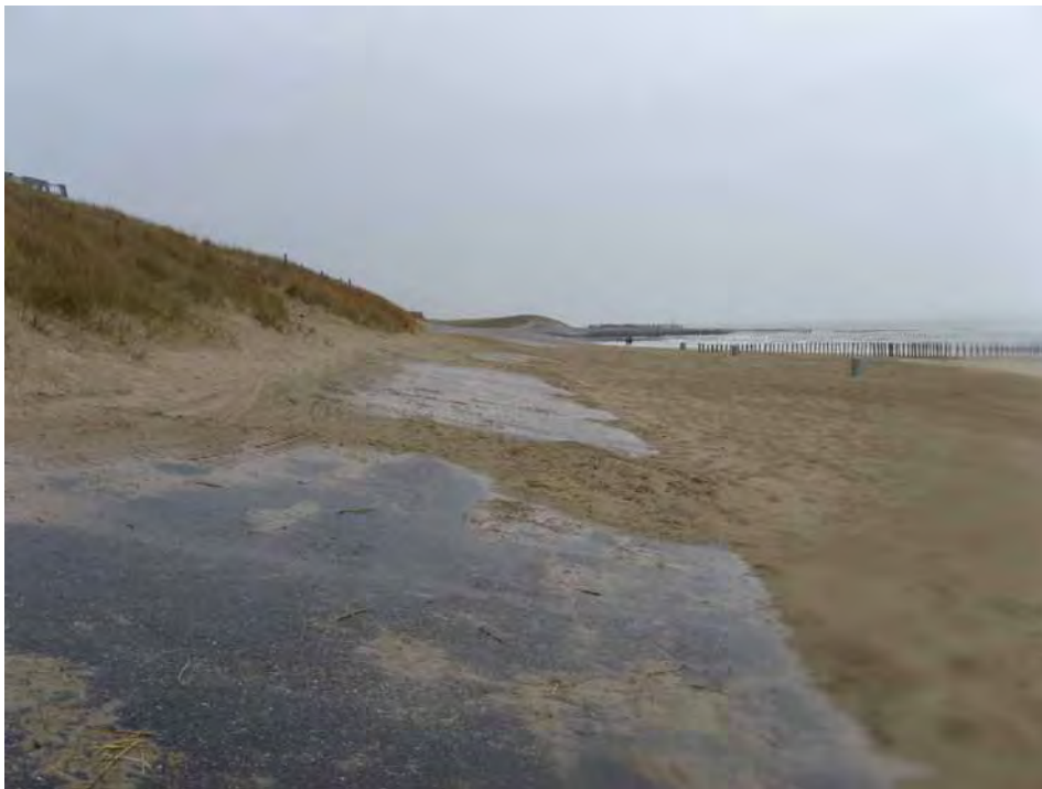
Foto Daar waar sprake is van een erosieve trend komt de dijkbekleding wel eens bloot te liggen.
