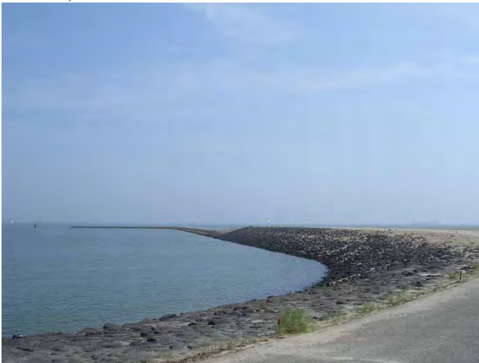
Foto De oostelijke dam van de Veerhaven.
