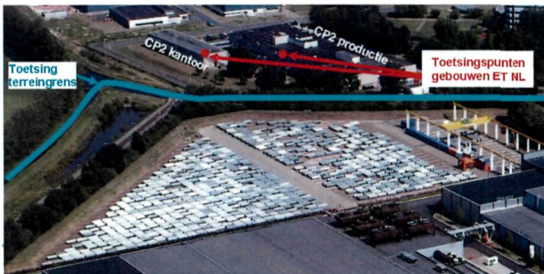
Overzicht toetsingspunten langs de containeropslagplaats
