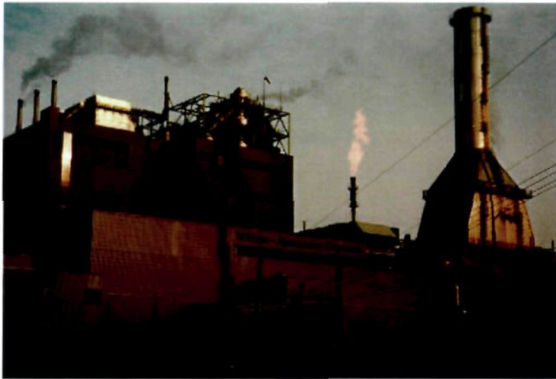
Figuur 3 De centrale in Buggenum met fakkelbedrijf voor overschakelen van de gas-turbine op syngas
