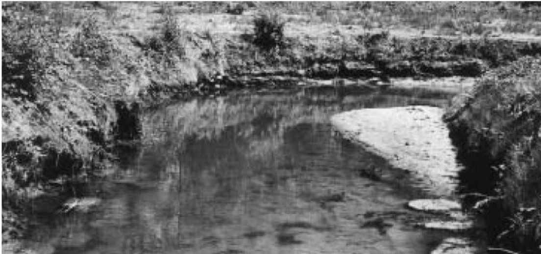
figuur 30: Meander van de Keersop enkele maanden na aanleg van de nieuwe geul (Wolfert, 2001)
