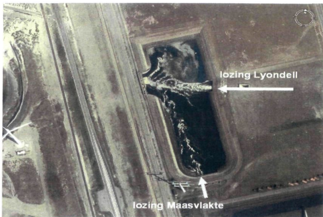
Figuur 4 Overzicht uitlaatvijver met rechts de uitlaat van Lyondell en onder de uitlaat van de centrale Maasvlakte. De afkoeling in de vijver is met CFD modellering berekend op circa 0,1 °C (bron: Google-earth)
