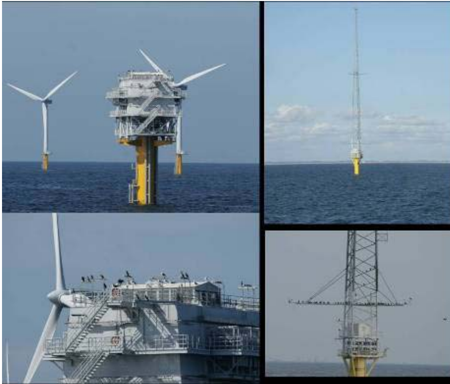
Figuur 6: Rustende Aalscholvers op het transformatorplatform van windpark Q7-Prinses Amalia (links, met linksonder een detail) en op de meteo-mast van windpark OWEZ (rechts, met rechtsonder een detail). Foto's Hans Verdaat.
