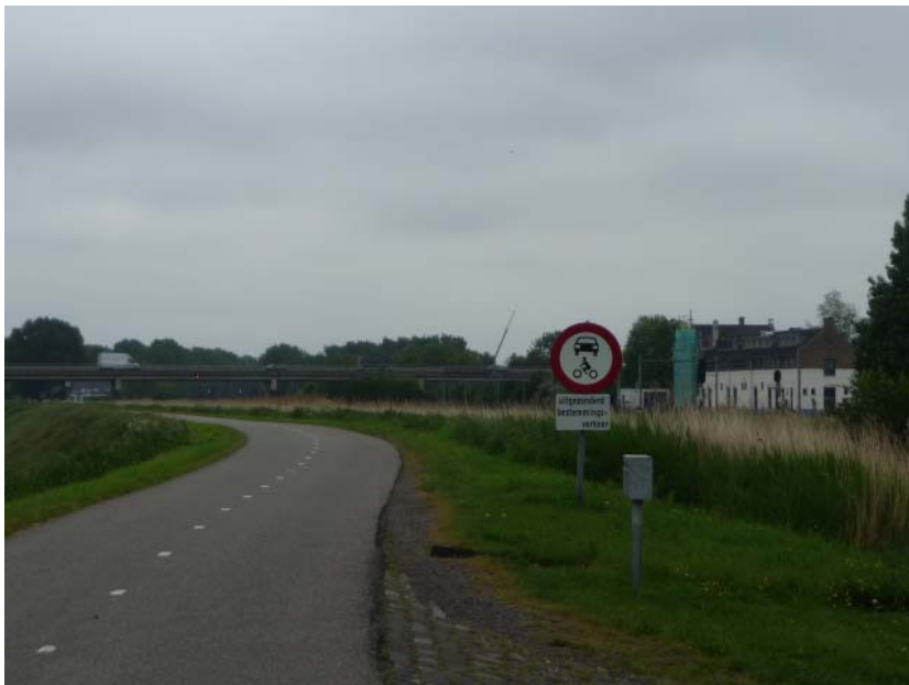
Foto van de viaduct van de N244 over de Purmerdijk en naastliggende vaart in zuidelijke richting.
