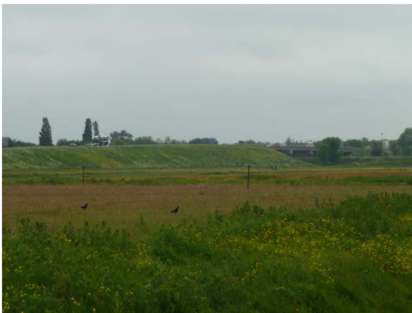
Foto van de viaduct van de N244 over Purmerdijk en naastliggende vaart genomen vanaf de Noordweg in zuidwestelijke richting. Diverse landerijen langs de N244 lijken – ten dele – een natuurlijke functie te hebben gezien het type begroeiing.
