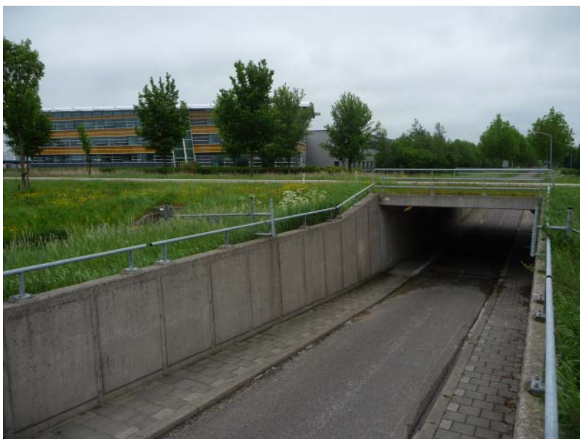
Westerweg met onderdoorgang onder de N244.
