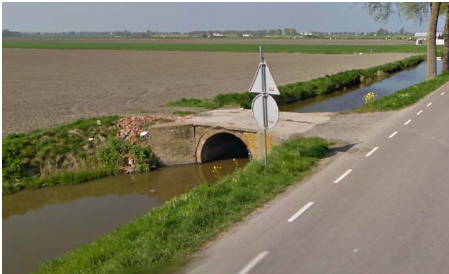
Afbeelding 2.2 Bruggetje/dammetje, met duidelijk puinmateriaal aan de Oosterweg ten noorden van de N244 (waarschijnlijk baksteen). (bron: Google Streetview)
