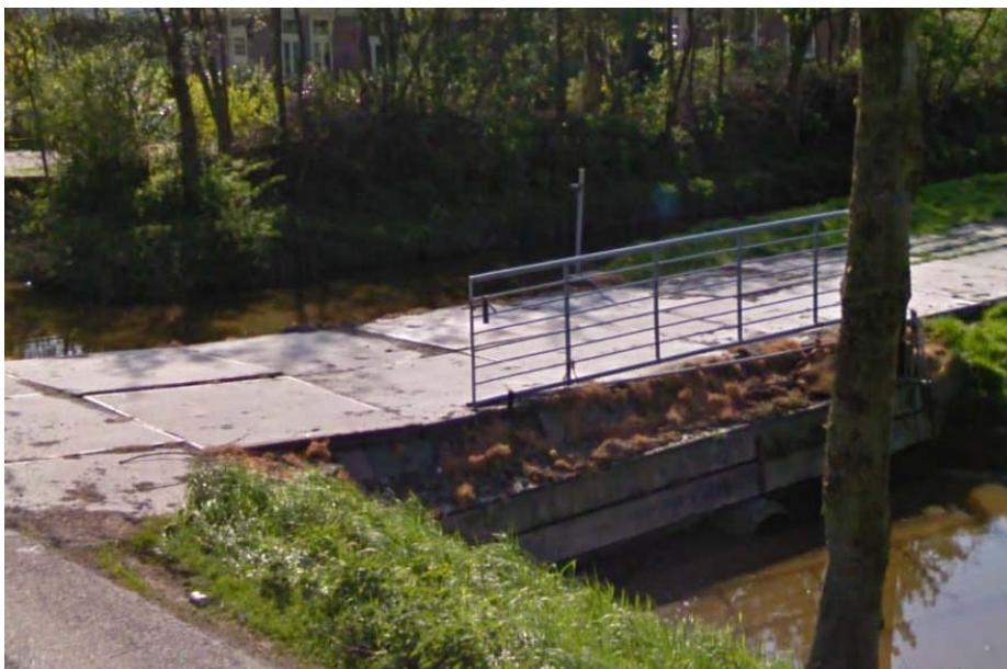
Afbeelding 2.3 Dammetje met onbekend materiaal aan de Oosterweg ten zuiden van de N244. (bron: Google Streetview)
