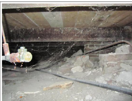
Afbeelding 1: Kruipruimte onder de woning
