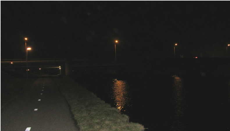
Foto 23: zicht op Broekervaart en viaduct N244, noordzijde N244
