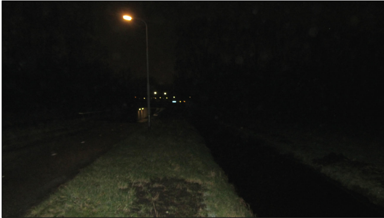
Foto 10: zicht op het water, berm en fietstunneltje Miedijk noordzijde N244
