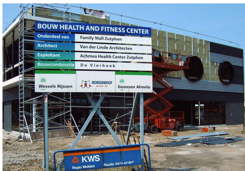
Figuur 5: Family Mall in aanbouw
