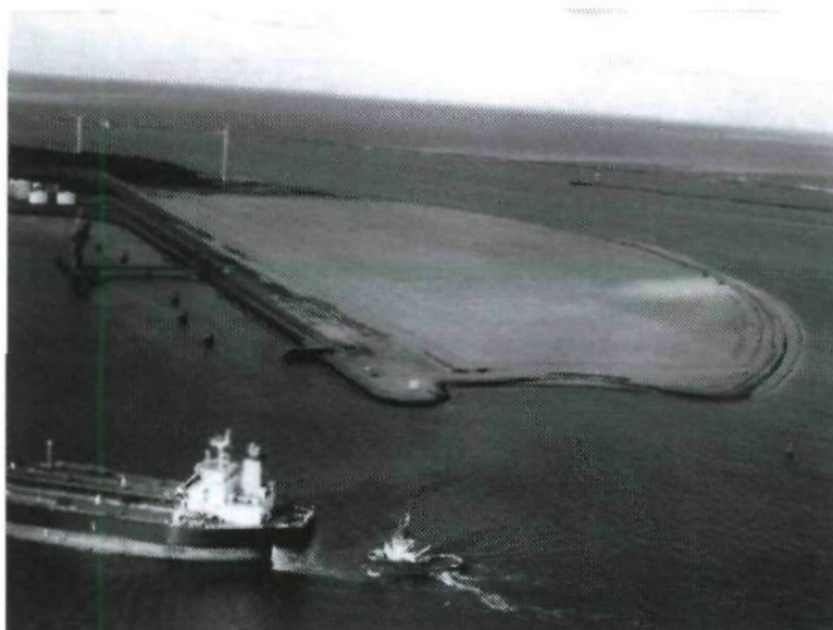
Figuur 4.2b De Papegaaiabek na ontmanteling van het baggerspeciedepot. (bron: RWS Zuid-Holland)
