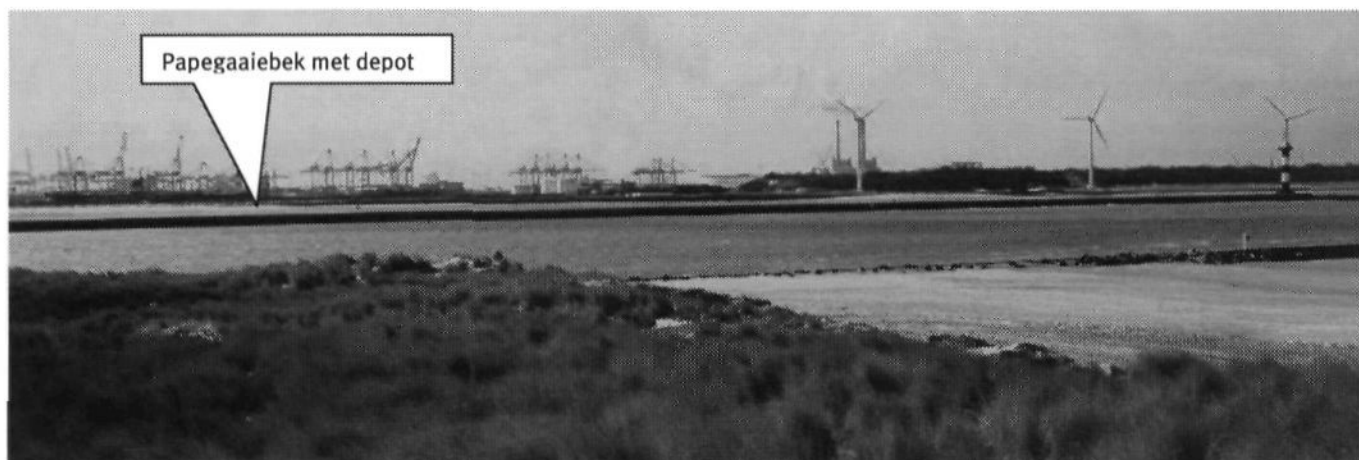
Figuur 4.7.a: Bestaande situatie vanaf het strand Hoek van Holland (januari 2006)
