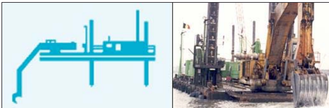
Figuur 2.6. Overzicht dieplepel techniek
