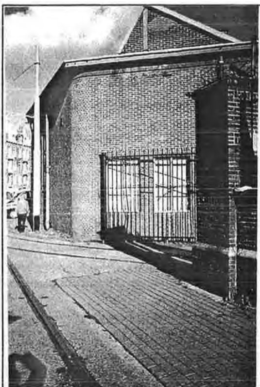
Locatie waar nieuw te bouwen kinderdagverblijf gerealiseerd wordt
