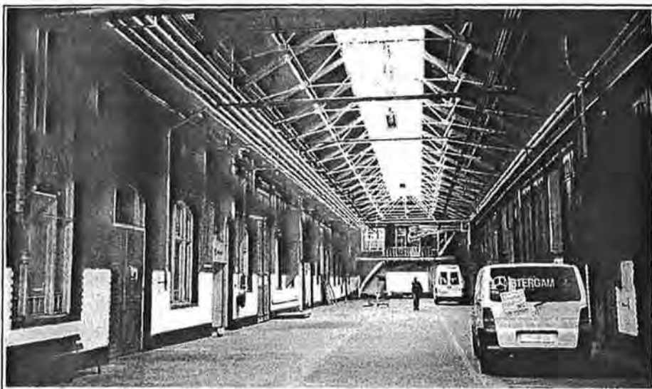
Draagconstructie met polonceauspanten
