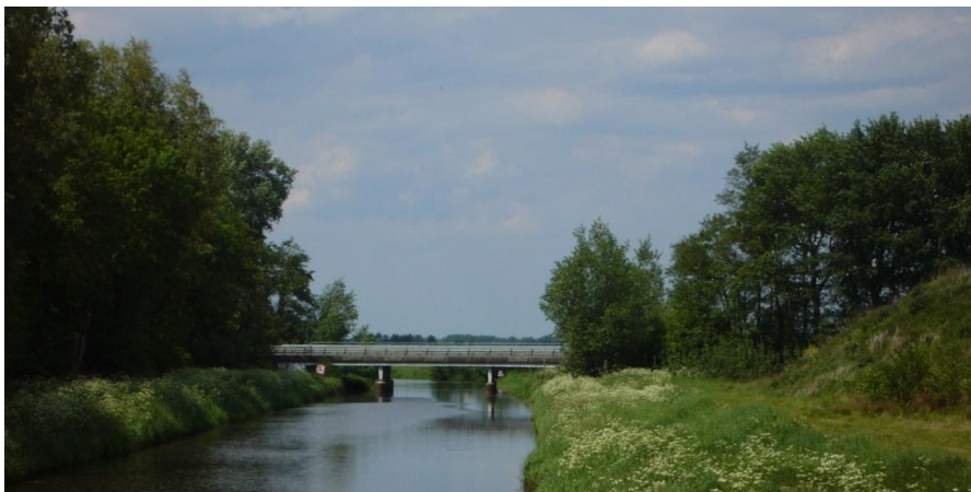
Figuur 14: Beekloop van de Hunze ten zuiden van N33. Zicht op de onderdoorgang bij de N33
