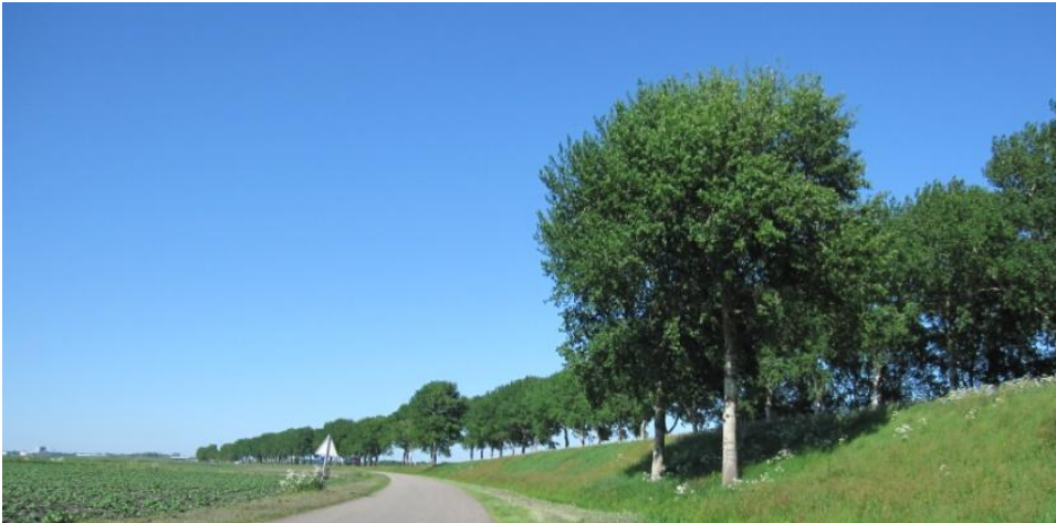
Figuur 20: Zicht op talud van de N33 in het Veenkoloniënlandschap
