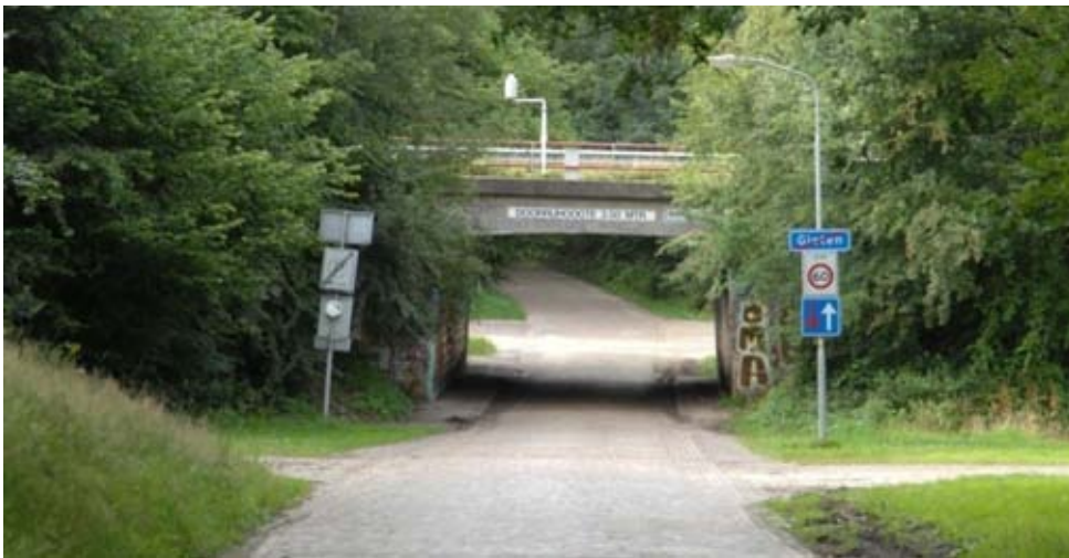
Foto G1: Onderdoorgang van de oude Groninger weg bij het Zwanemeer. Zicht in noordelijke richting.
