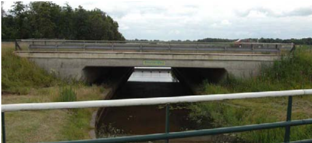
Foto C4: Deurzerdiep/Amerdiep onderdoorgang gekanaliseerde loop ten noorden van N33. Zicht in zuidelijke richting.
