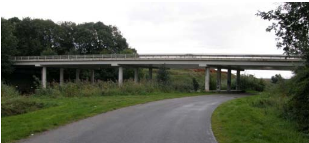
Foto I1: Brug over Veendam-Musselkanaal. Zicht in oostelijke richting.
