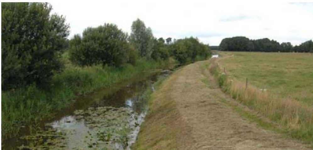
Foto C5: Deurzerdiep/Amerdiep gekanaliseerde loop aan de noordzijde van de N33. Zicht in noordelijke richting.
