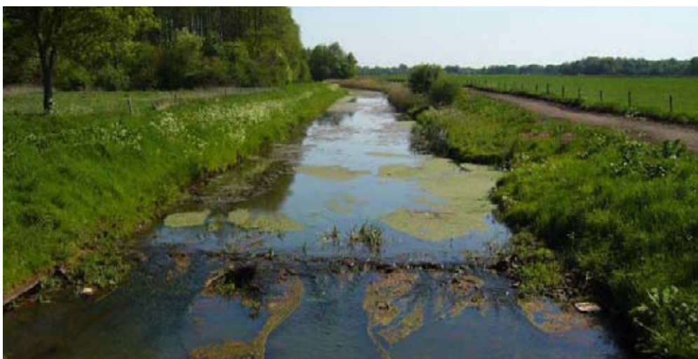
Foto C3: Deurzerdiep/Amerdiep gekanaliseerde loop aan de noordzijde van de N33. Zicht in noordelijke richting.
