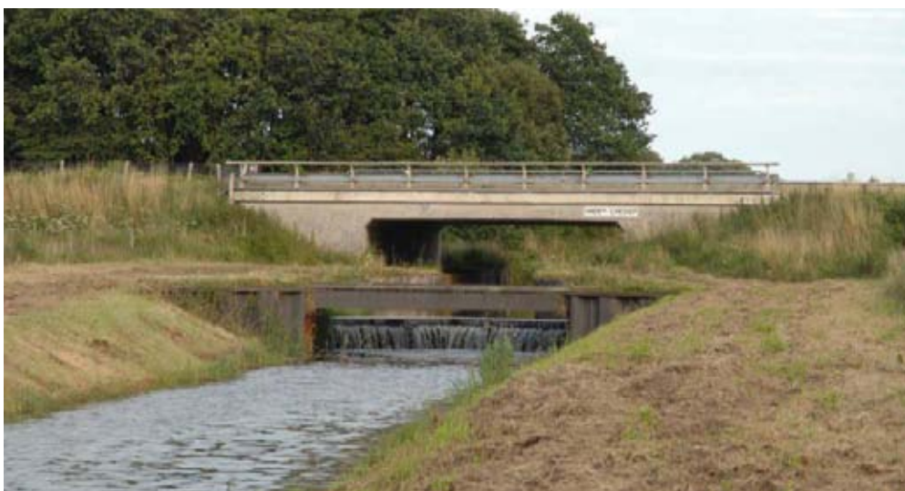
Foto E2: Rolderdiep onderdoorgang ten noorden van N33.
