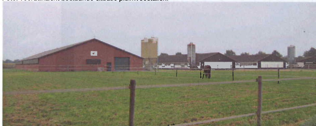
Foto: vooraanzicht bestaande situatie pluimveestallen.
