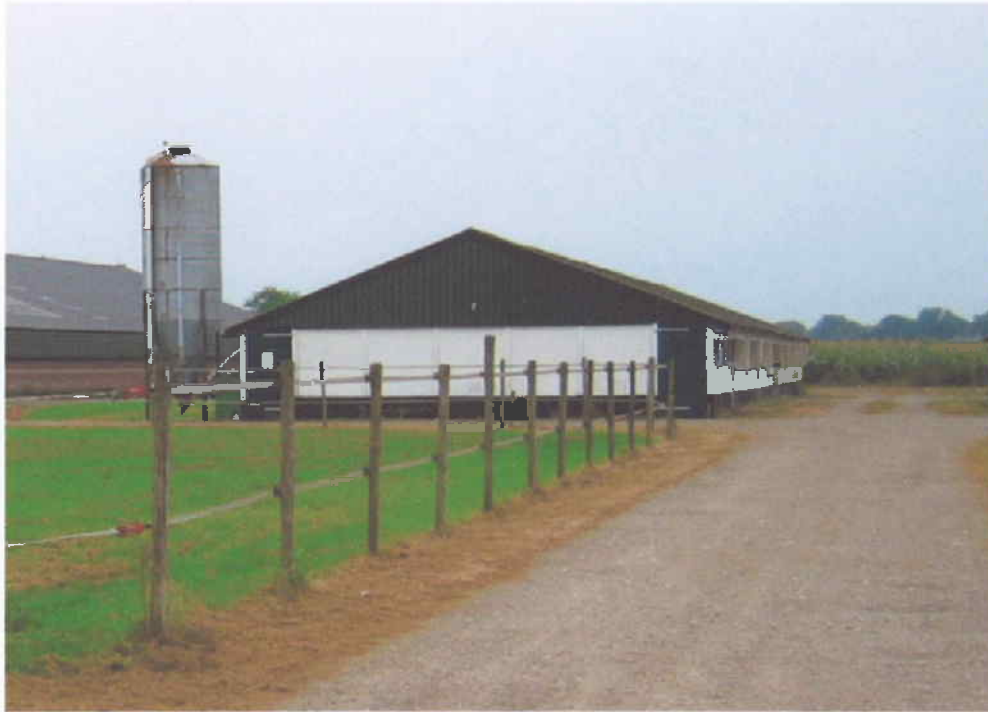
Foto: te slopen pluimveestal
