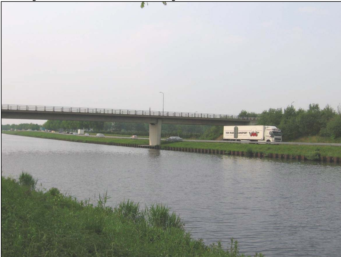
afbeelding 2.8 Overzicht kanaal en N279 ter hoogte van Middelrode
