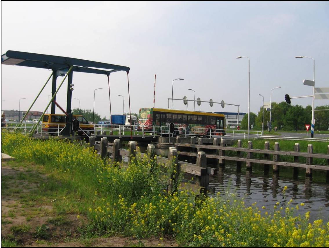
afbeelding 4.1 De Dungense brug
