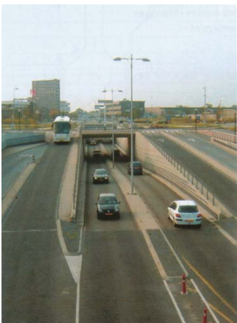
Een voorbeeld van de OVN-capaciteitsmaatregel 'vrije doorgaande stroom' die door het terugdringen van congestie tegelijk de uitstoot vermindert (bron: CROW publicatie 225 Ontwerpsuggesties onderliggend wegennet+ (2005) )
