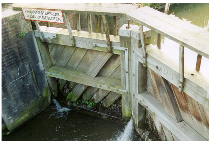
Figuur 4 sluislek bij Kraaijenestersluis
