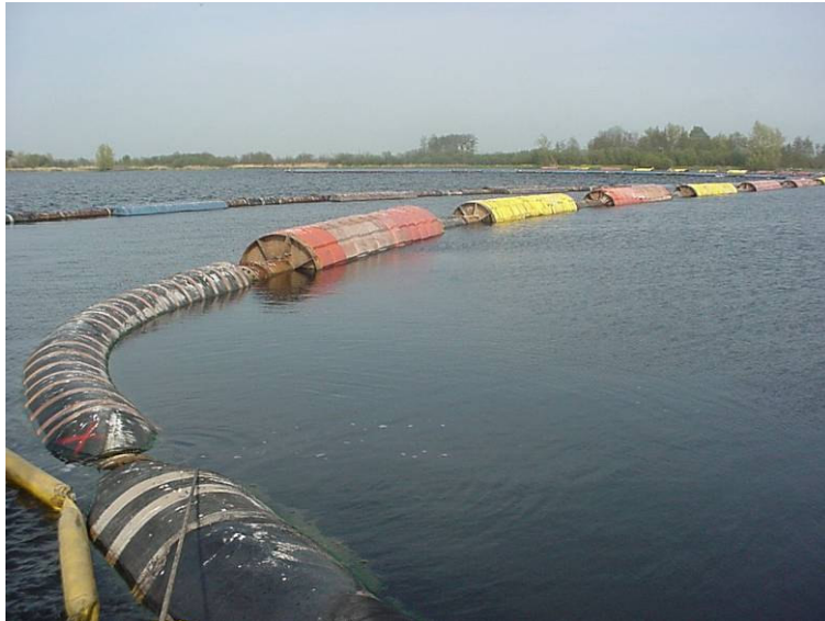
Figuur 21 drijvende persleiding zoals die in het Wijdmeren-alternatief gebruikt wordt tijdens het bezanden: door een dergelijke leiding wordt het zand van de onderzuiger naar de sproei-installatie gepompt.
