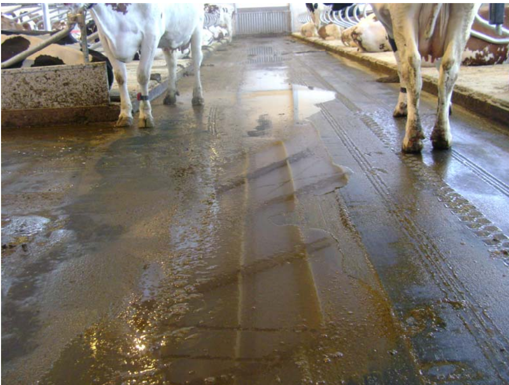
Foto 2. 2% hellende gietasfaltvloer zonder kelder met regelmatige mestverwijdering door mestschuif.
