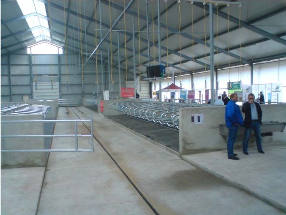
Foto 1. 2% hellende betonvloer zonder kelder met regelmatige mestverwijdering door mestschuif
