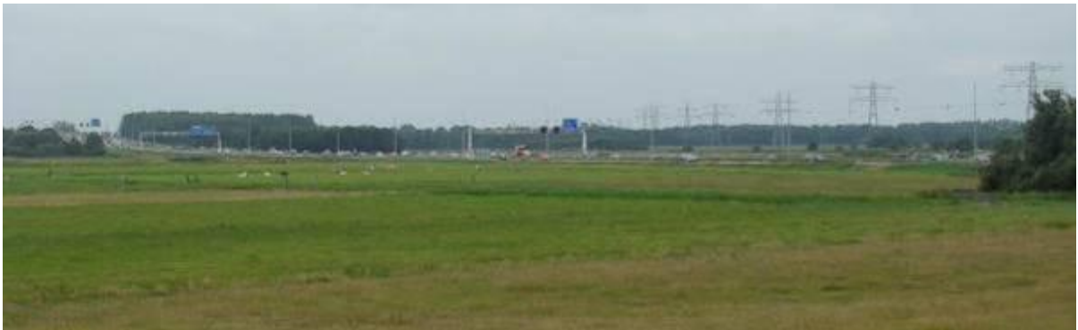
Figuur 4.3 De infrastructuurlijnen van de A9 en de huidige 150 kV-verbinding drukken een duidelijk stempel op het relatief open veenweidegebied van de Verenigde Binnenpolder, foto genomen in noordelijke richting
