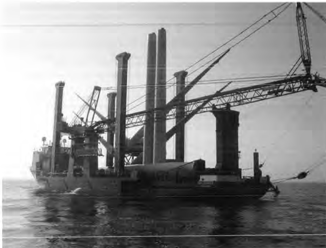
Afbeelding 3-2 Installatie turbine (bron: windpark Q7)
