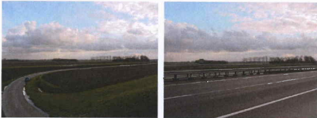
Afbeelding 2.1. Foto's situatie 2006: Voor start van de bouw op Agriport 1
