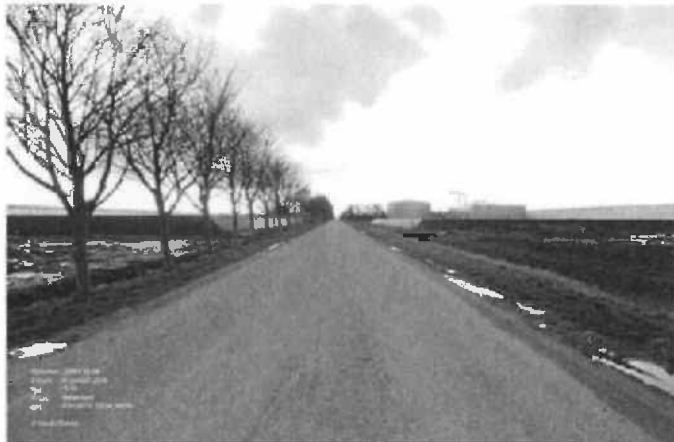
Afbeelding 2.13. Foto werkelijke situatie tijdens bouw januari 2008
