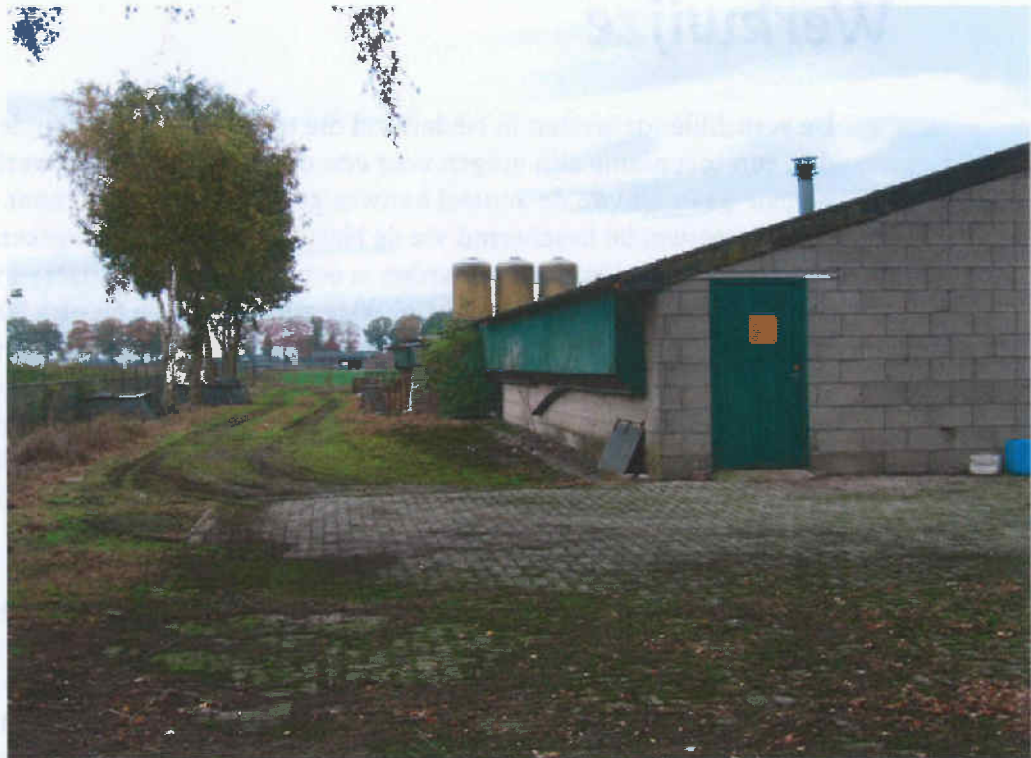
De stallen van de bestaande boerderij.
