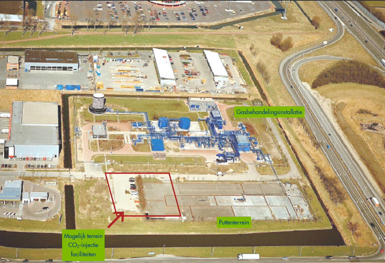
Figuur 6: De locatie Barendrecht en naastgelegen gasbehandelingsinstallatie.
