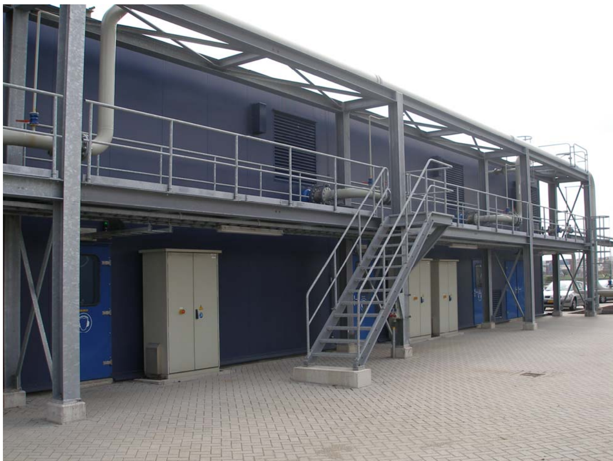
Bestaand compressorgebouw in Pernis.
