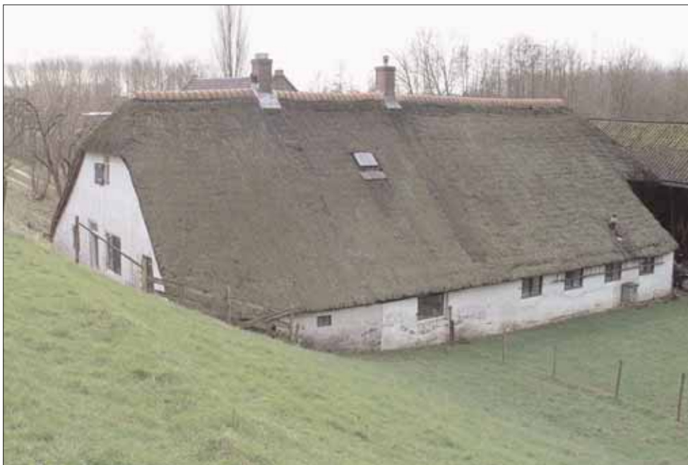
Figuur 7. Boerderij deels gelegen in het dijklichaam. Aan de Hollandse zijde van de Diefdijk spoorde overlast van kwelwater aan tot vestiging in de dijk om hoger en droger te kunnen wonen.
