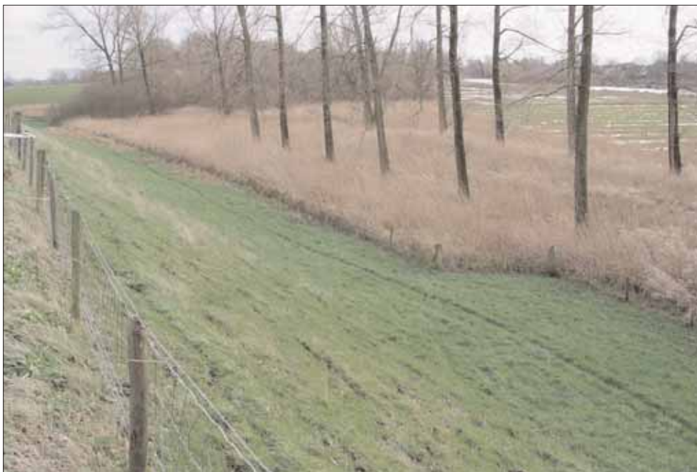
Figuur 16. Rietlanden en rabatten herinneren in de uiterwaarden langs de Meerdijk aan aardhaling voor dijkherstel en -versterking. De Meerdijk is heel wat keren vergraven, met name wegens plaatsing en verlegging van sluizen.
