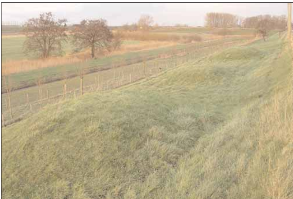
Figuur 22. Aarden relictten van de opstelling van een nevenbatterij bij fort Everdingen; het geschut moest de verdediging van het acces rond de Lekdijk ondersteunen.
