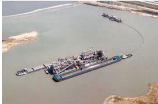
Afbeelding Zandzuiger en Drijvende klasseerinstallatie (bron Samenwerking Lobberdense Waard)
