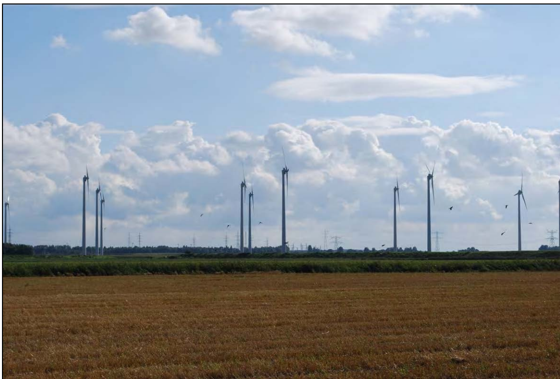
Figuur 2.2. Beeld van het windturbinepark in de Anna Mariapolder (ashoogte 70 meter, rotordiameter 52 meter, tiphoogte 96 meter)
