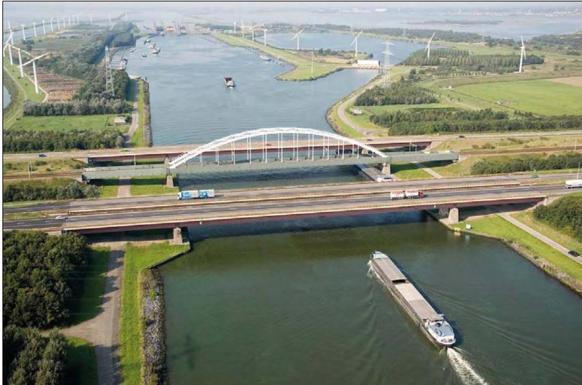
Figuur 2.1. Beeld van het huidige windturbinepark met het knooppunt van infrastructuur
