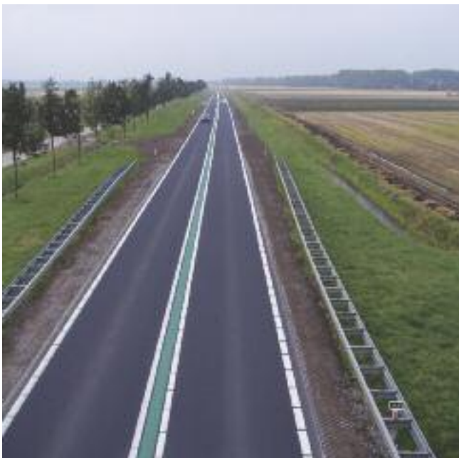
Figuur 2.1 Tractaatweg (N62), huidige situatie ter hoogte van de Spuikreekweg
