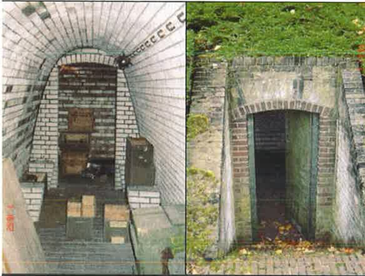
Figuur 4.3 Foto links binnekant bunker, foto rechts ingang bunker
