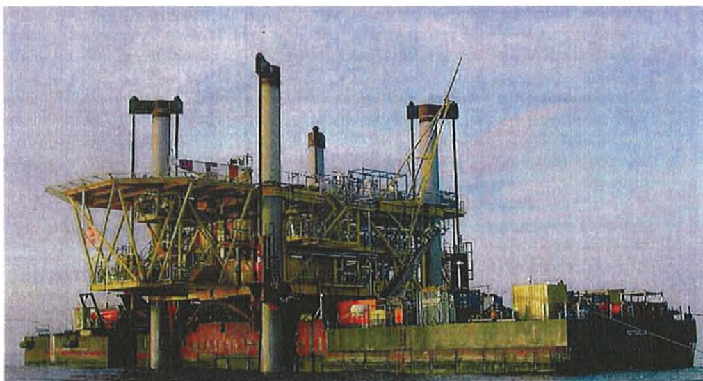
Fig. 4.1.a Het platform wordt vanaf het transportdek met een tijdelijke hijsinstallatie op hoogte gebracht. Het dek en de hijsinstallatie worden vervolgens weer naar de wal gesleept.
