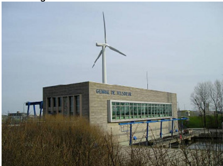
afbeelding 3.2. Gemaal De Helsdeur
