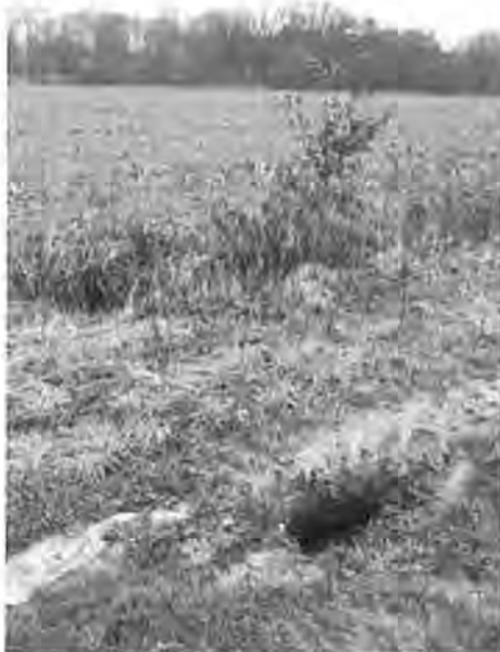
Foto 4: Ingestorte gang/kamer van burcht 2 onder zandpad
