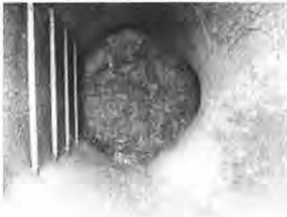
Foto 8 Inspectieput van dassentunnel vol met nestmateriaal van das.
