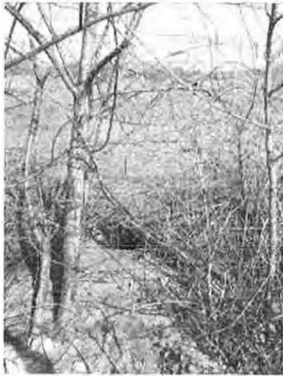
Foto 6: Vluchtpijp (VI) in houtwal nabij dassentunnel B
