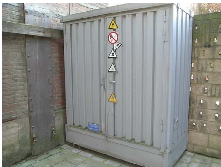
01. Opslagcontainer voor chemicaliën, brandwerend en met lekbak
