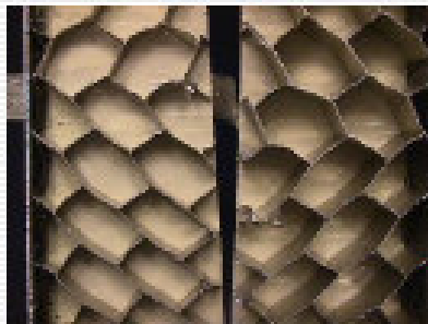
Figuur 5.5 Full-contact drijvend dak, met honingraatstructuur voor stevigheid. Bron: 2006 Storage Tank Conference onder leiding van de Baker Consulting Group
