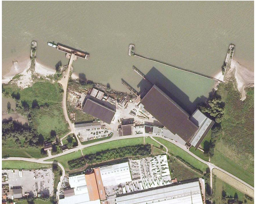
Luchtfoto ter plaatse van de scheepswerf Ravestein
