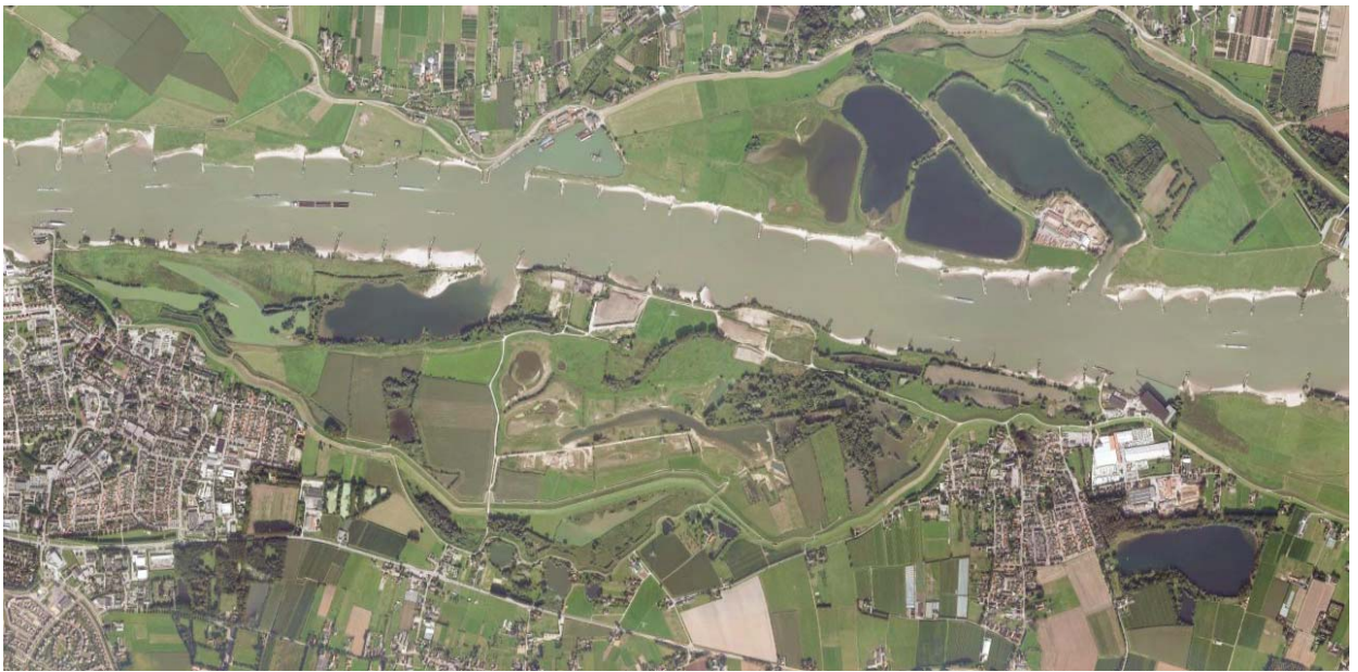
Luchtfoto Afferdense en Deestse Waarden
