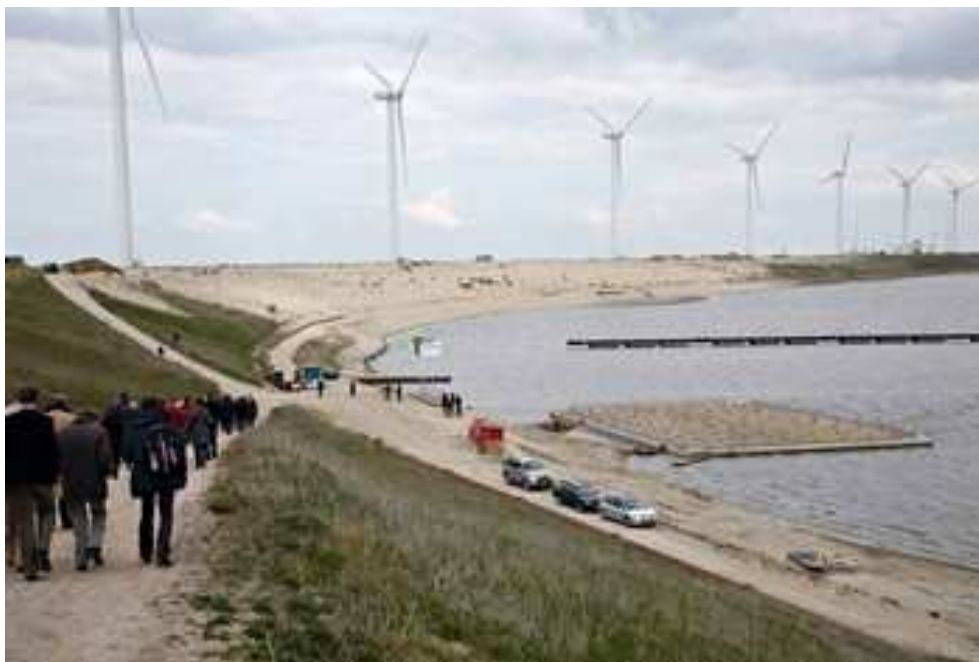
Figuur 7 Slufter Maasvlakte Rotterdam
