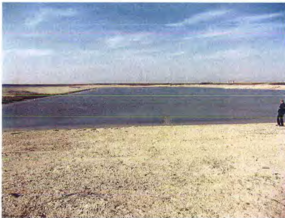
Figuur 4. Ontgraven zanddepot in de eindfase.
