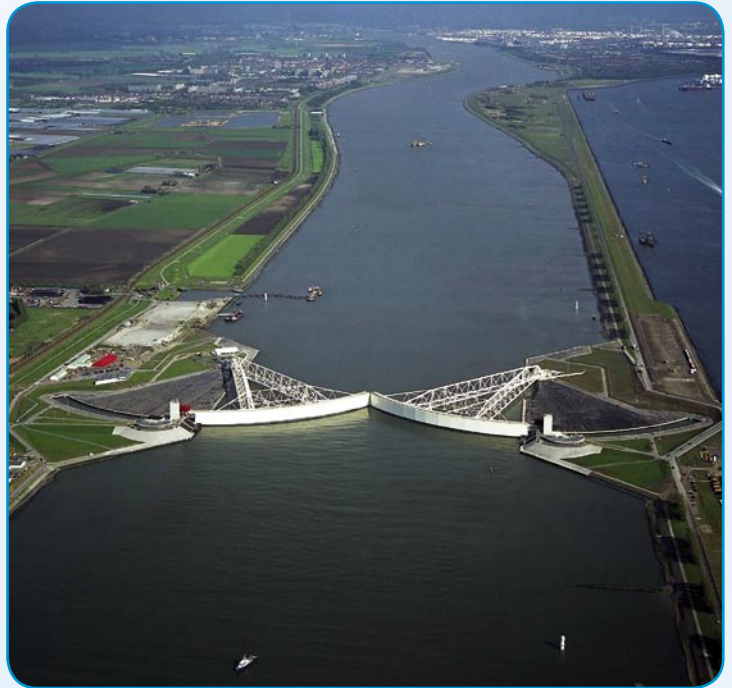
Gesloten Maeslantkering in de Nieuwe Waterweg.
