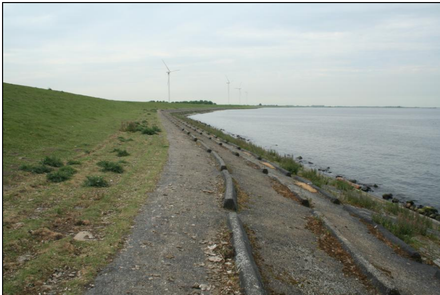
Het onderzoeksgebied, achter de Sasdijk te Dintelsas
