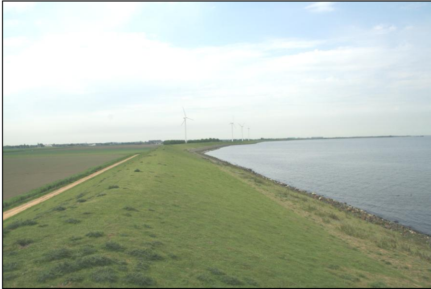
Het onderzoeksgebied, achter de Sasdijk te Dintelsas
