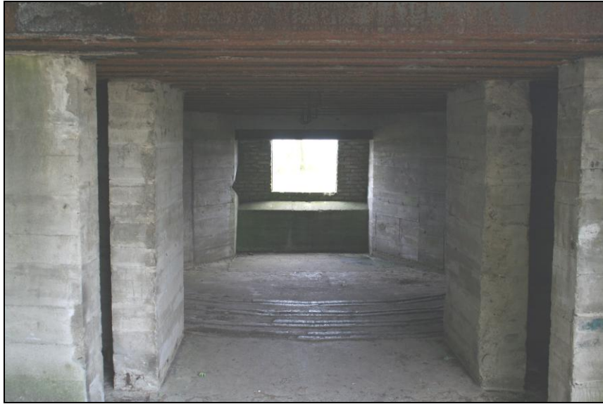
Binnenzijde van de bunker nabij de schutsluis ter plaatse van het Benedensas te Steenberg
