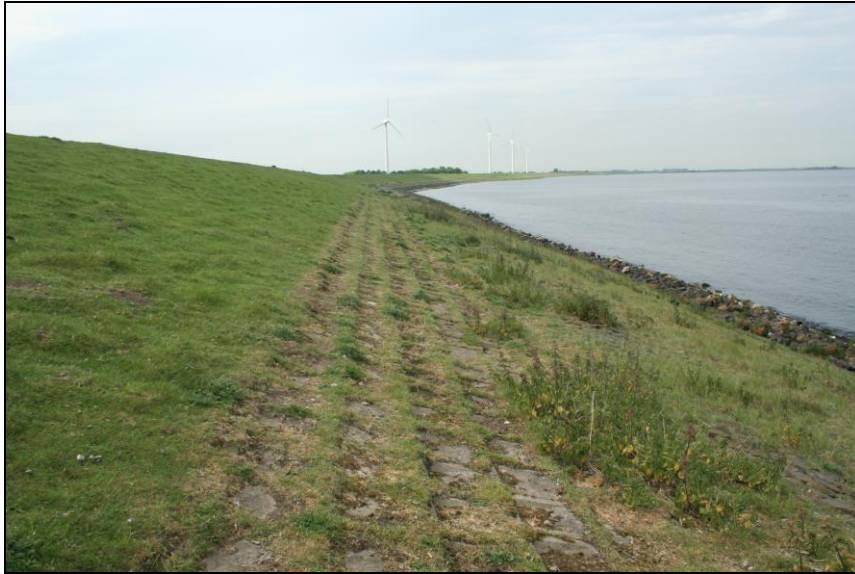
Het onderzoeksgebied, achter de Sasdijk te Dintelsas
