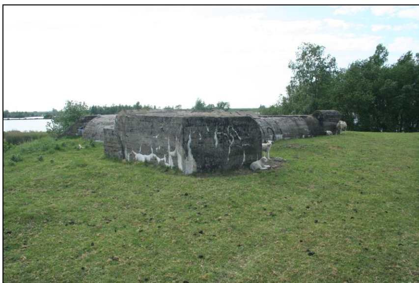
Bunker in de Auvergnepolder: totaaloverzicht
