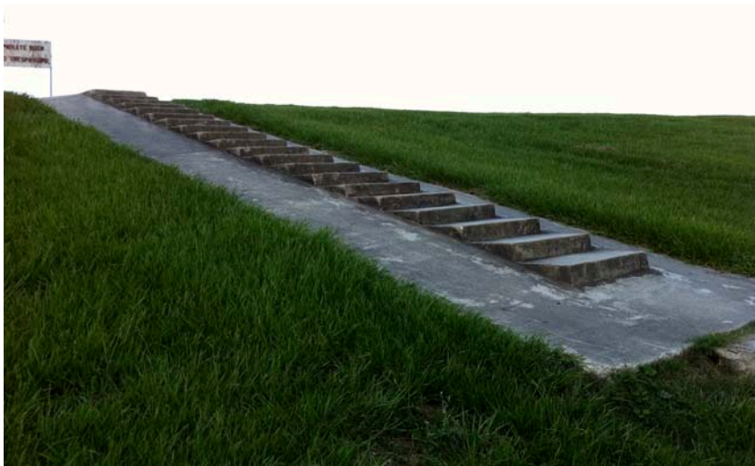
Referentiebeeld van een dijktrap die óp het talud ligt langs de Mississippi in New Orleans. De betonnen rand aan de zijkant is iets te grof.
