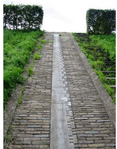
Waterpeilschaal met dijktrap prachtig geïntegreerd in het dijktaalud (referentie Sleeuwijk)
