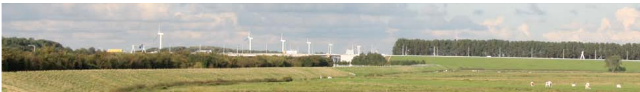
Afnemende zichtbaarheid van het sluiscomplex Volkerak door beplanting
