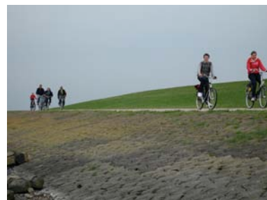
Referentiefoto fietsroute over een onderhoudspad van de zeedijk op Terschelling
