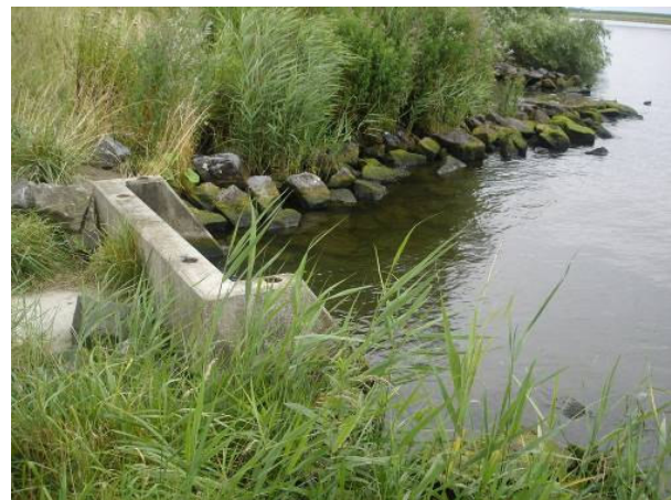
Figuur 4 Uitgang van duiker (kanaalzijde)
