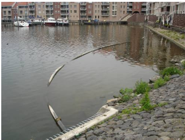
Figuur 3 Drijfvlagen afzuiginstallatie
