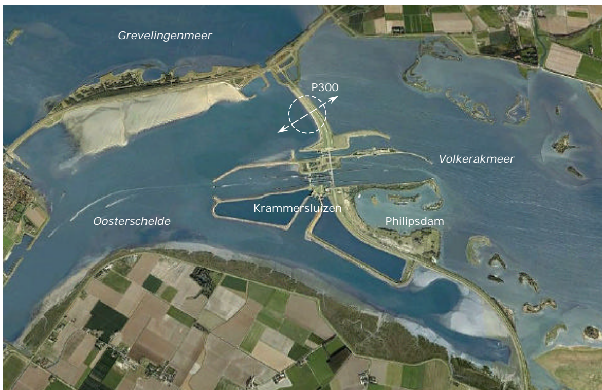
Figuur 2-5 Locatie P300 nabij Krammersluizen.
